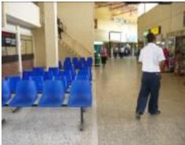
Pasillos de Terminal
