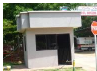
Garita que controla salida de Buses y Vehículos del Terminal
